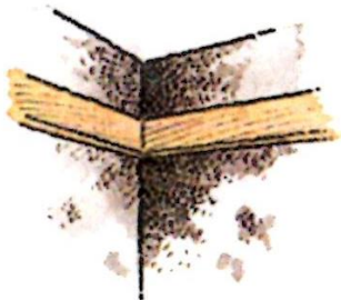
壁の隅に汚いシミカビ発生
