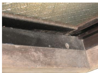
押入れ内部天井部分 サッシ窓下部分のカビ発生ヶ所
